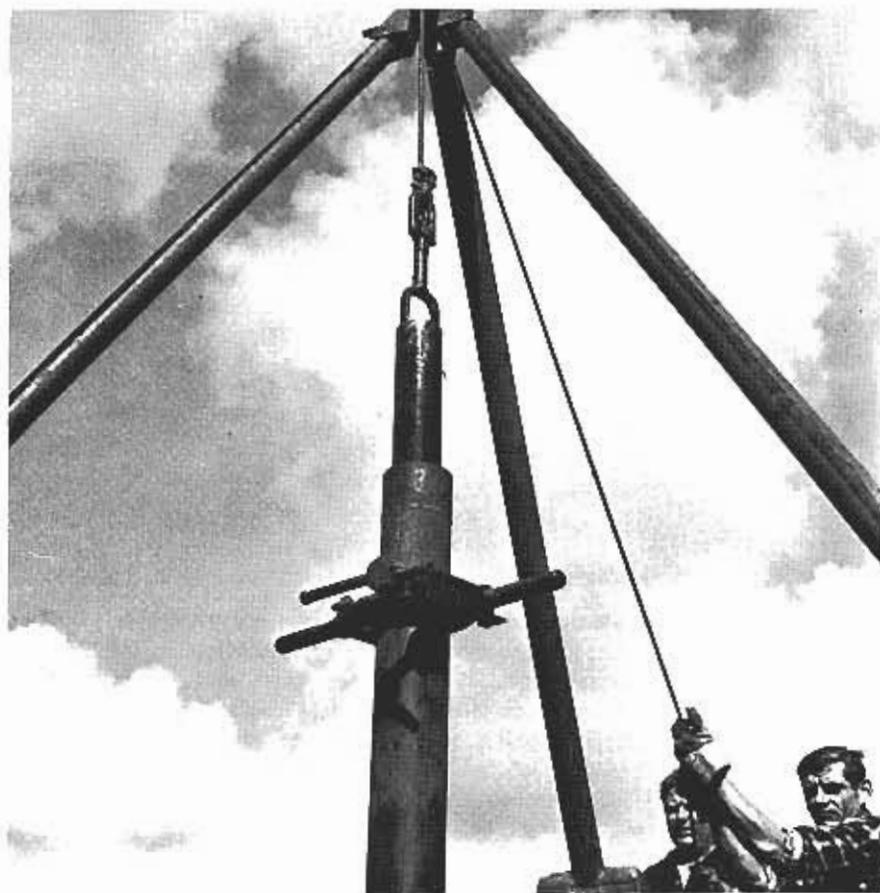
Abb. 6. Bohrerüst mit Ventilbohrer.
