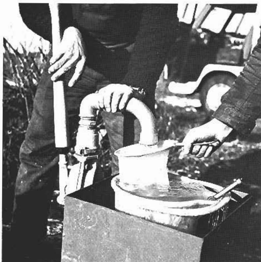
Abb. 11. Entnahme einer biologischen Probe aus einem Rohr der P-Station Liebenau.
